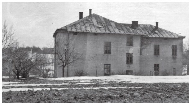
1952 r. budynek szkoły przed rozbudową. źródło: Kronika Szkolna
