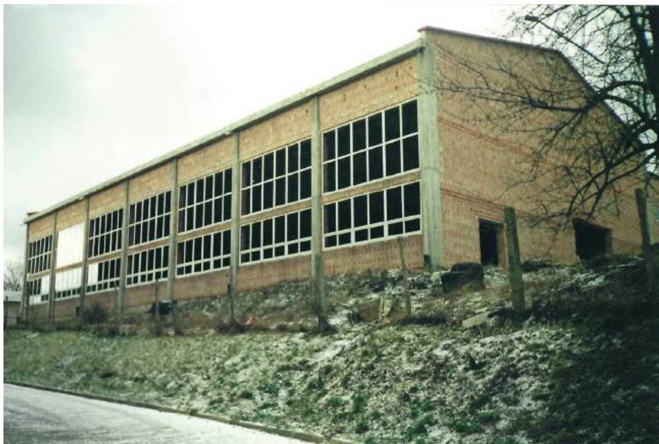
2001 r. Hala sportowa w czasie budowy. Fot. ze zbiorów Jana Semkowa
